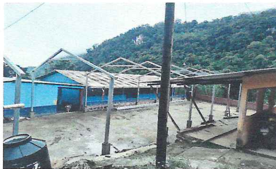
Foto 6: Se colocaron todas las estructuras metalicas y las costaneras que sostiene las laminas.
