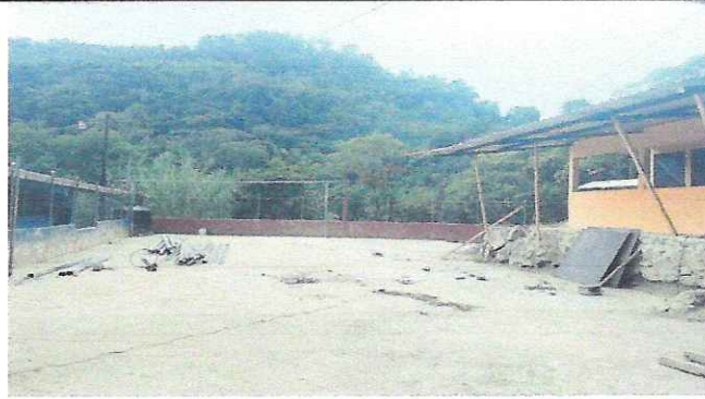
Foto 2: Se despejo el area donde se va a trabajar.
