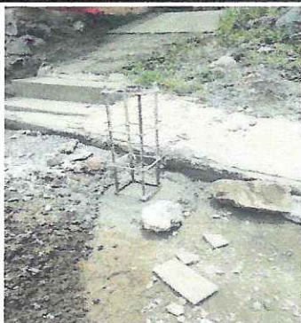
Foto 3: Se fundio para posteriormente levantar las estructuras metalicas.
