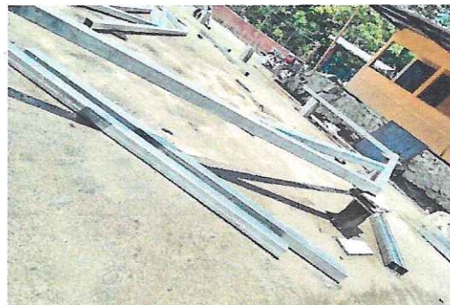
Foto 4: Se formaron las estructuras metalicas.
